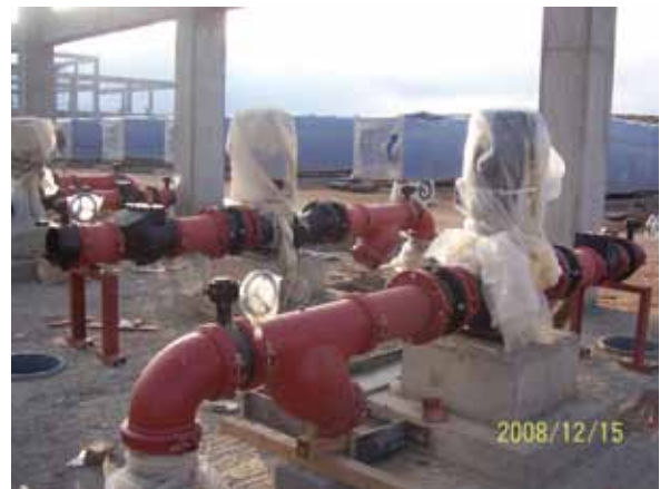
Modelo 726 Filtro Estilo "Y", válvulas de mariposa SJ-300N y válvulas de control SJ-900 utilizados en un sistema de agua fría.
