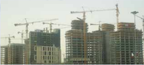
Sistemas de Aire Acondicionado, Ventilación y Calefacción, el rey Abudullah Financial District, Reino de Arabia Saudita
