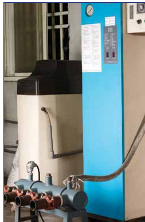
Las pruebas de laboratorio de agua caliente
