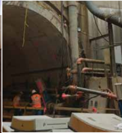
East Side CSO proyecto de perforación de túneles, Portland, OR
