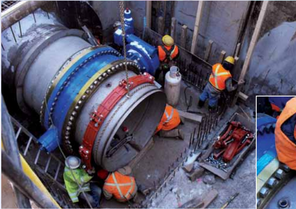
72" R88 acoplamientos utilizados en la Planta de Tratamiento de FJ Horgan, Ontario, Canadá
