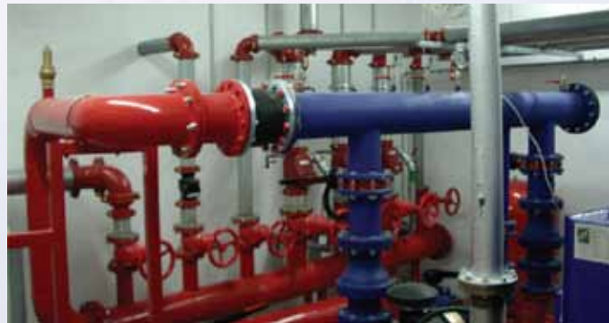
Sistemas de Aire Acondicionado, Ventilación y Calefacción, Praktiker almacén, Iraklion Krete, Grecia
