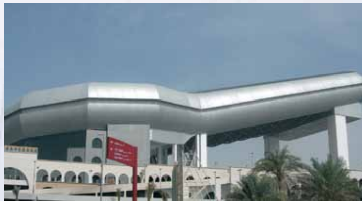
Tubería de Glycol - Domo de Ski, Dubai, UAE
