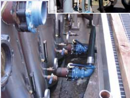
Múltiples conexiones, la lluvia y apartamentos, Las Vegas, NV
