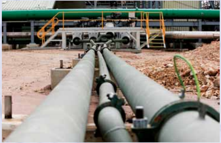
Ash purines y los gasoductos de alta presión de agua, Queensland, Australia
