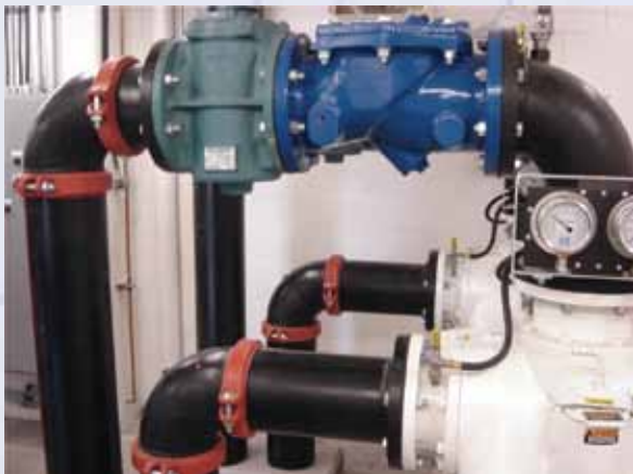
Aguas Residuales Regionales del Lado Oeste Planta de Tratamiento, BC, Canadá
